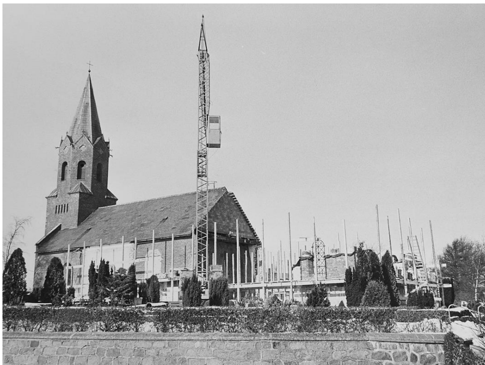
Om- og tilbygningen i 1969
