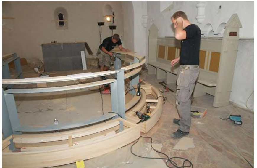
Renovering ude og inde
